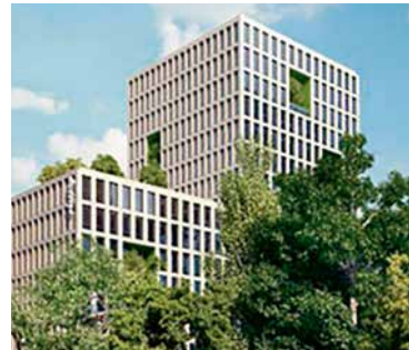
LANCY PONT ROUGE, GENÈVE PONT 12
